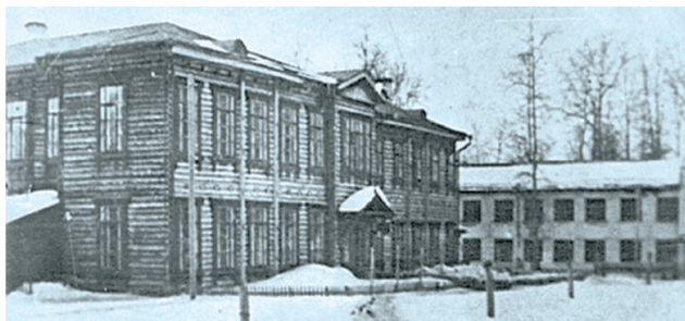
Здания школ № 1 (слева) и № 2
