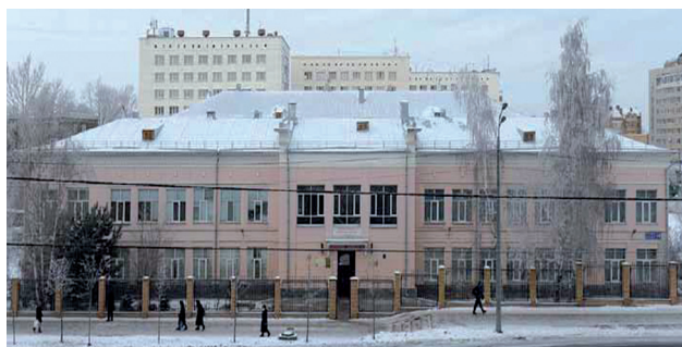
Гимназия № 27 в Вахитовском районе г. Казани
